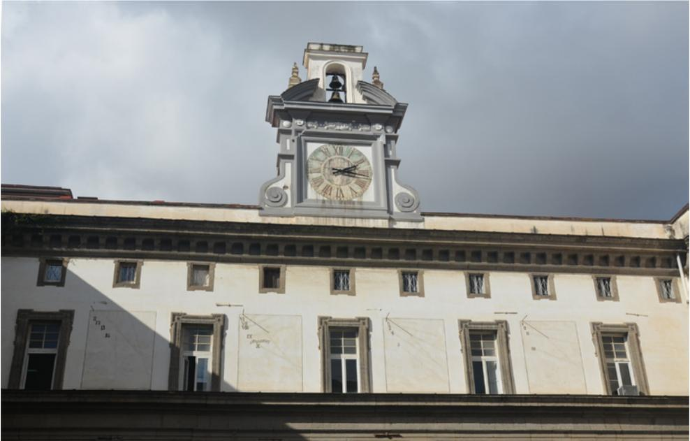
Fig. 4. Facciata occidentale del Cortile delle Statue. In evidenza i quadranti dei quattro orologi solari con gli stili di ferro, le linee orarie ed i numeri; perduta invece la decorazione pittorica.
